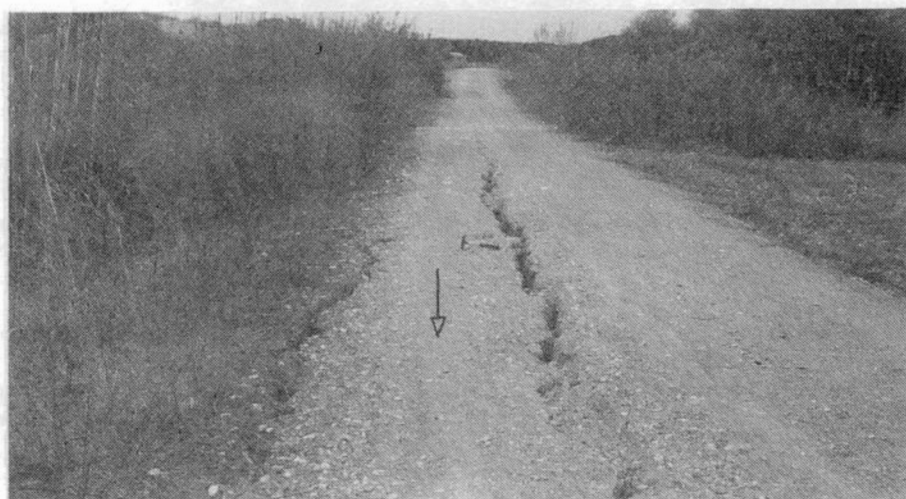
Εικ. 2. Εδαφικές διαρρήξεις διεύθυνσης NNA-BBΔ κατά μήκος του αγροτικού δρόμου Βαρθολομιού-Μπούκας. Οι διαρρήξεις έχουν άλμα της τάξης των 5-10 εκατοστών με αποτέλεσμα το ενδιάμεσο μικρο-τέμαχος να έχει ταπεινωθεί σε σχέση με τα εκατέρωθεν ευρισκόμενα.
